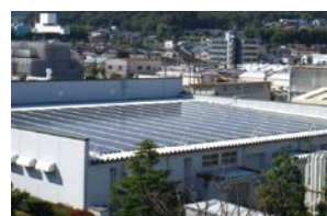
基盤技術センター屋上
