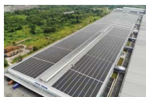
マレーシアのタイヤ工場屋上
