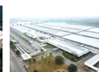
マレーシア工場
