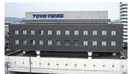
屋上に太陽光発電パネルを設置したタイヤ技術センター（兵庫県伊丹市）
