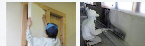
戸建住宅用ノンフロン断熱材「アイタス」の施工 現場発泡の硬質ウレタンフォームの吹付け施工
