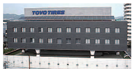
屋上に太陽光発電パネルを設置したタイヤ技術センター(兵庫県伊丹市)
