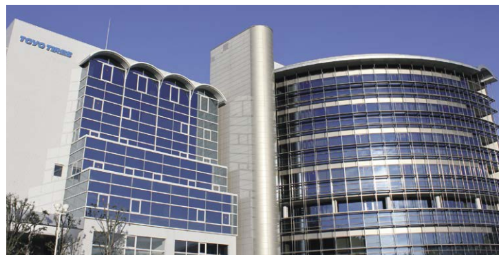
基盤技術センター(兵庫県)
